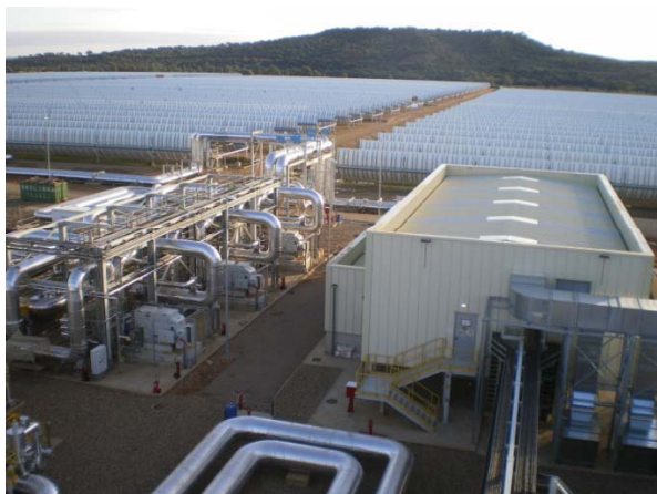
Edificio HTF y Rack de Bombas
