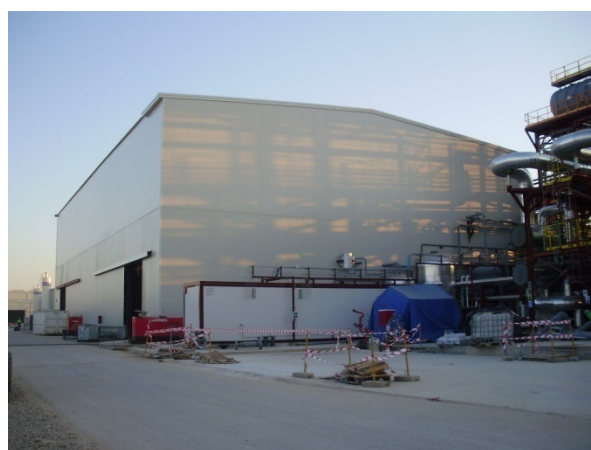
Edificio de Turbina
