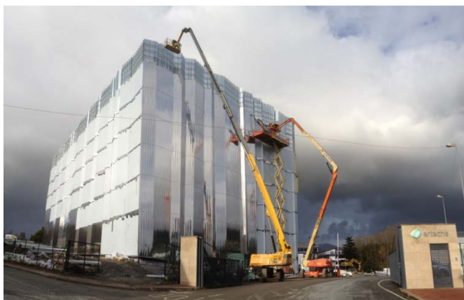
Montaje de lamas de acero inoxidable
