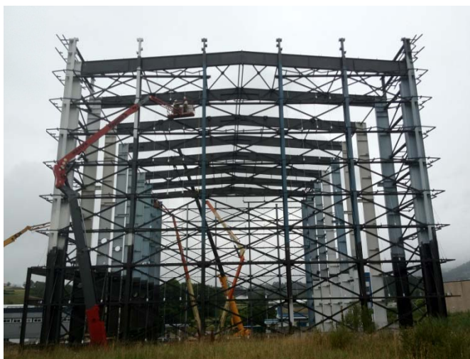
Montaje Estructura Principal
