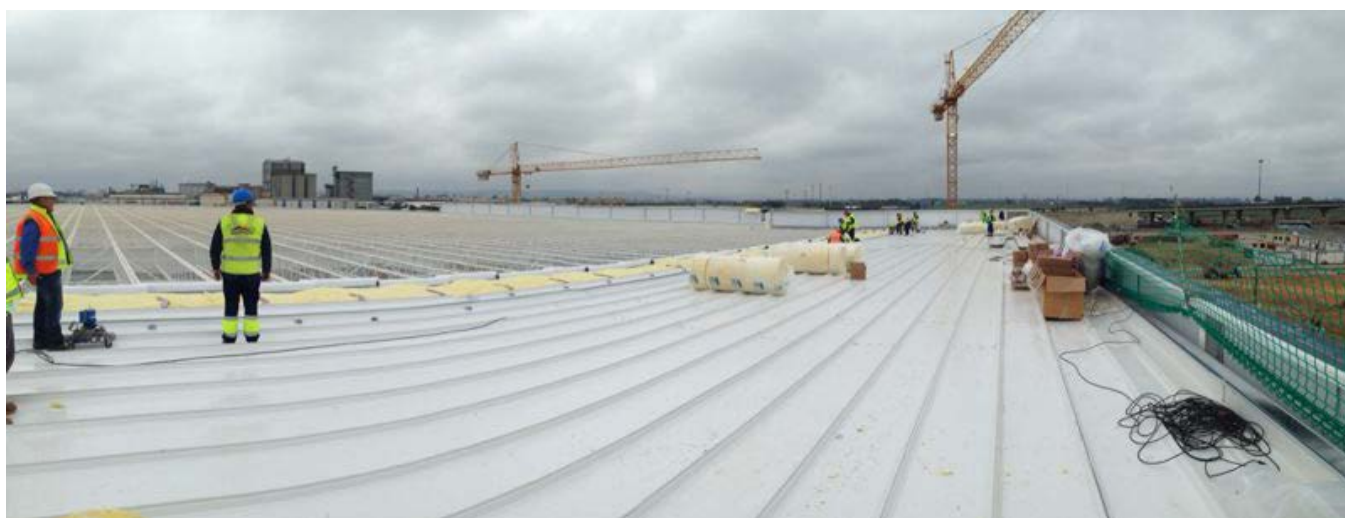
Proceso de engatillado del MR-24
